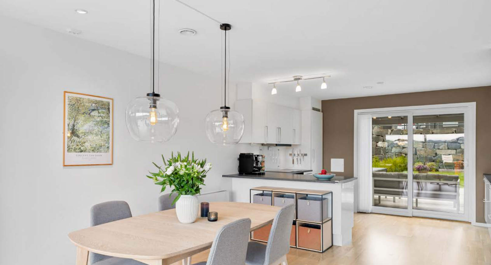
Vannbåren oppvarming via viftekonvektor (i bakkant av spisebordet).
