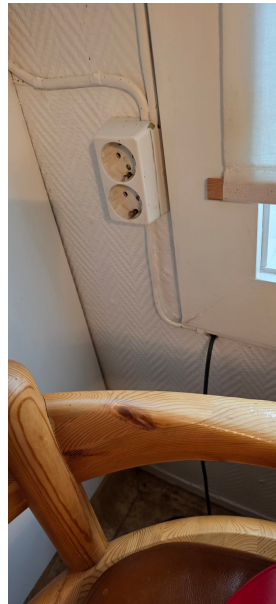
Bilde 2 Mangler en letti ved stikk. Kjøkkenvindu.
