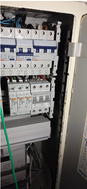
Bilde 1 Mangler tilkoblet jord på overspenning.
