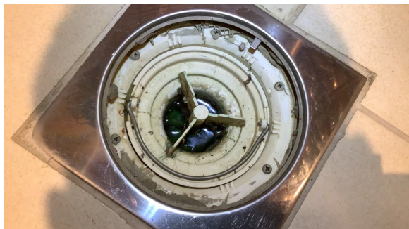
Plastsluk, og det er synlig tettesjikt rundt sluk.
