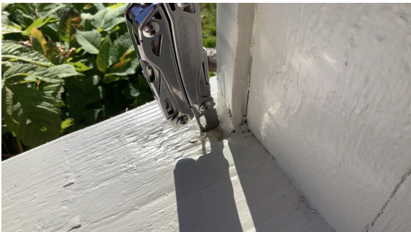
Råteskadet håndløper.
