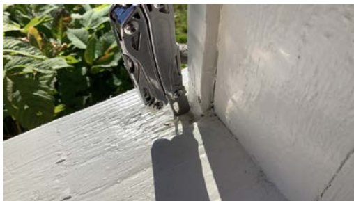
Råteskadet håndløper.
