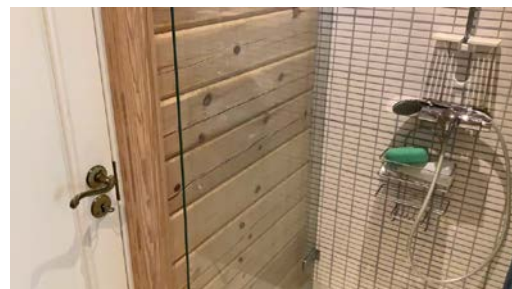
Glassvegg er tettesjikt mot tømmervegg.
