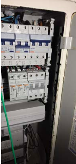
Bilde 1 Mangler tilkoblet jord på overspenning.
