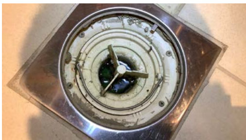
Plastsluk, og det er synlig tettesjikt rundt sluk.
