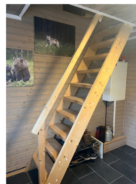
Plassbygget trapp til hems/loftetasje.
