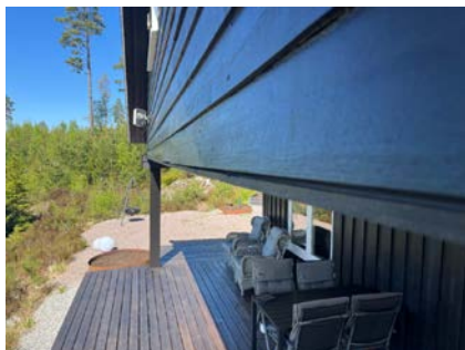
Svai på gavl til hems/loftetasje.
