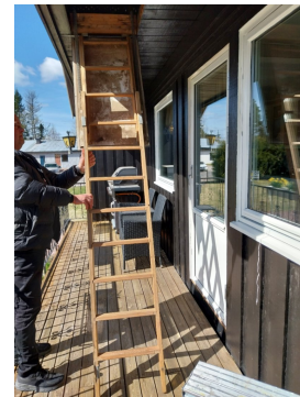
Loftsluke med stige, utvendig plassert ved tilbygget.
