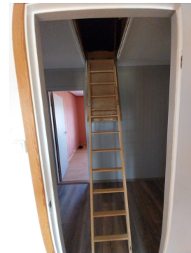
Loftsluke med stige i gang/korridor
