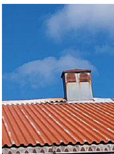
Avtrekkshatt med rustdannelse.
