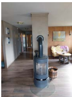
Vedovn i stue 1.etasje (opprinnelige del)
