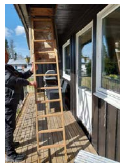
Loftsluke med stige, utvendig plassert ved tilbygget.
