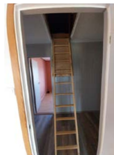
Loftsluke med stige i gang/korridor
