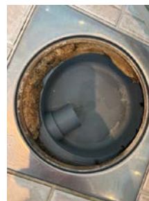
Kontroll av hjelpesluk i dusjsone.
