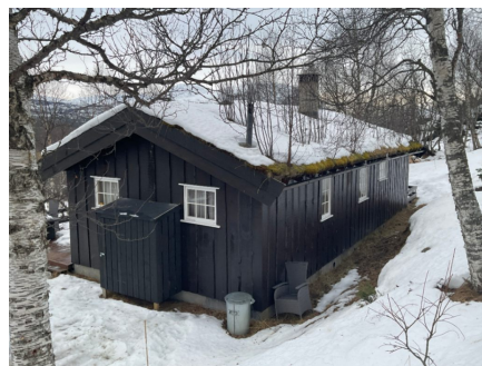
Bilde fra befaring i 2025
