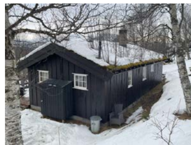
Bilde fra befaring i 2025
