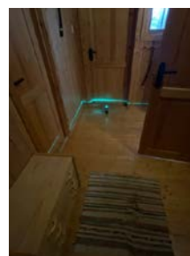
Ca 25mm høydeforskjell gjennom rommet i gang.
