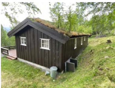
Bilde av tomten tatt ved befaring i 2023.
