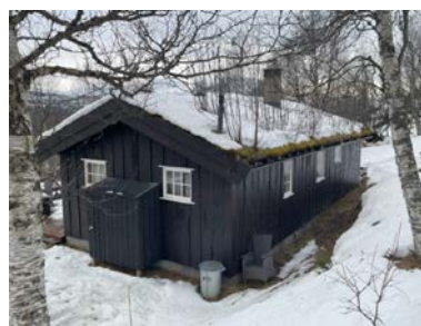
Bilde fra befaring i 2025
