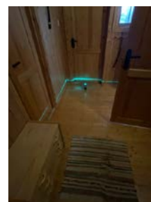
Ca 25mm høydeforskjell gjennom rommet i gang.
