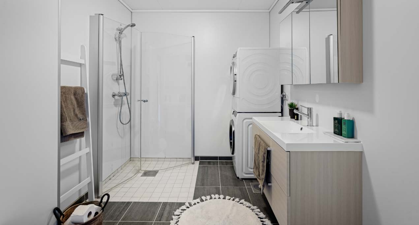
Bad med fliser på gulv og våtromsplater på vegg.
