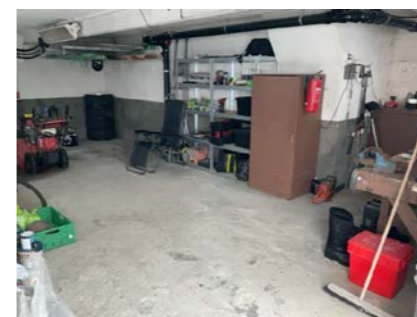
Utett brannskille ved avløpsrør.
