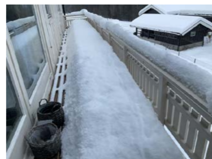
Rekkverkshøyde på 65cm.
