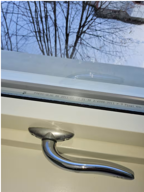
Bilde viser datering av vindu fra 2011.
