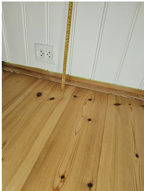
Bilde viser måling av etasjeskiller.
