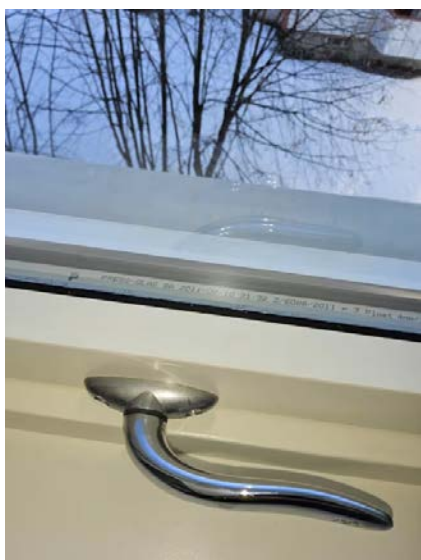
Bilde viser datering av vindu fra 2011.
