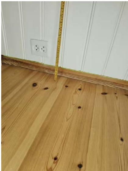
Bilde viser måling av etasjeskiller.
