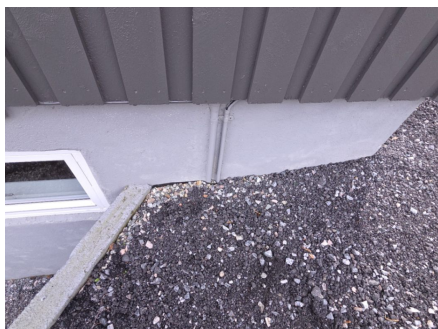
Bildet viser grunnmursplast uten kantlist.
