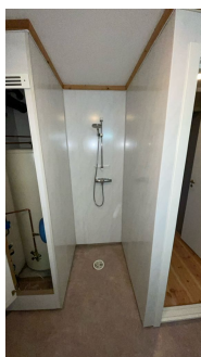
Oversikt mot område ved dusj og plassbygd skap ved varmtvannsbereder
