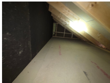
Oversikt kryploft mot vest
