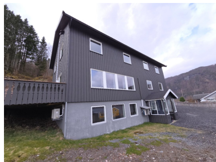
Vindu i front på stue og soverom
