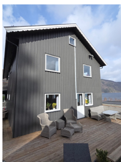
Det er montert takstige fra loftsvindu
