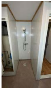
Oversikt mot område ved dusj og plassbygd skap ved varmtvannsbereder
