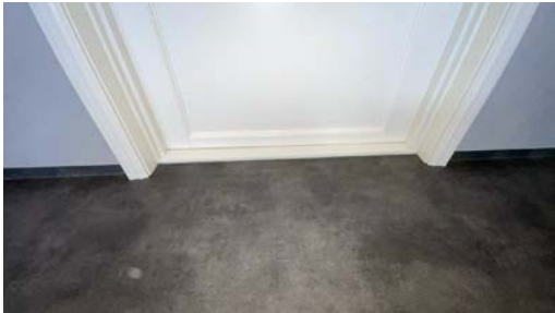
Luftespalte under dør er etablert etter befaringen
