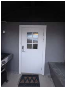
Hoveddør i underetasjen med kodelås
