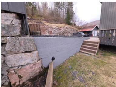
Forstøtningsmur fra uthus/garasje mot boligen
