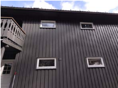
Vindu på vaskerom, stue, toalett og bod
