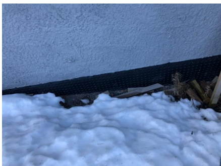
Utvendig synlig fuksikring av grunnmur på gavlvegg.
