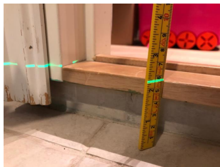
Fall mot sluk er målt med laser.
