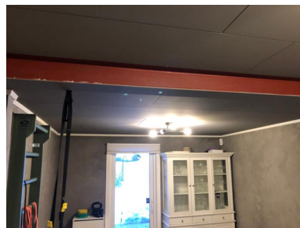
Jernbjelke i kjellerstuen som ikke er innkasset
