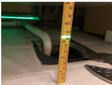
Fall mot sluk er målt med laser.
