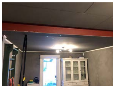
Jernbjelke i kjellerstuen som ikke er innkasset
