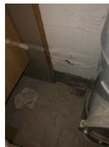
Saltutslag og noe avskalling av maling/puss
