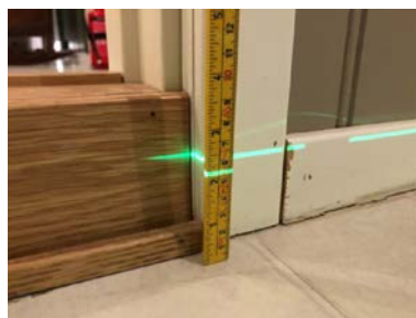
Fall mot sluk er målt med laser.
