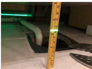
Fall mot sluk er målt med laser.
