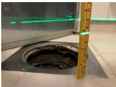
Fall mot sluk er målt med laser.
