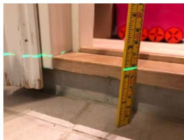
Fall mot sluk er målt med laser.
