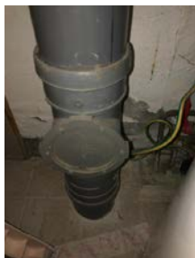
Stakeluke er plassert på bad/vaskerom i u.etg
