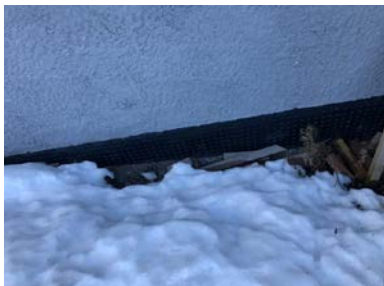
Utvendig synlig fuktsikring av grunnmur på gavlvegg.
