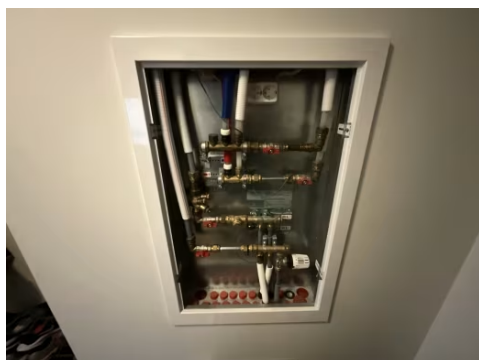
Fordelerskap for vann/vannvarme/stoppekraner i gang.
