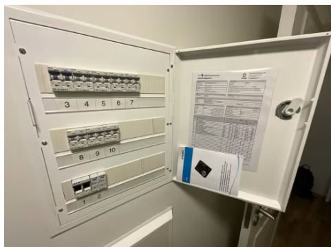
El-skap i bod.
