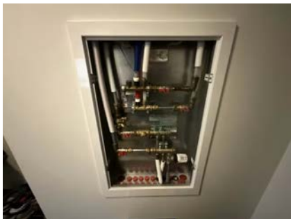
Fordelerskap for vann/vannvarme/stoppekraner i gang.
