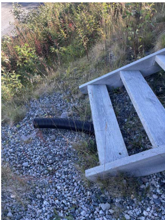
Drenering er ført ut fra bygget, ned til privat grøft.
