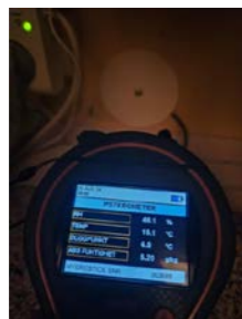
Måling av relativ luftfuktighet i veggkonstruksjon mellom kjøkken og bad.
