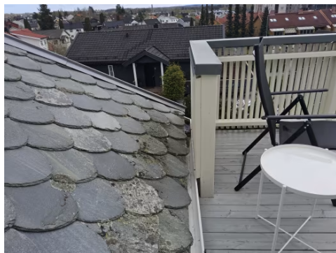
Rekkverk er avsluttet mot tilstøtende takkonstruksjon.
