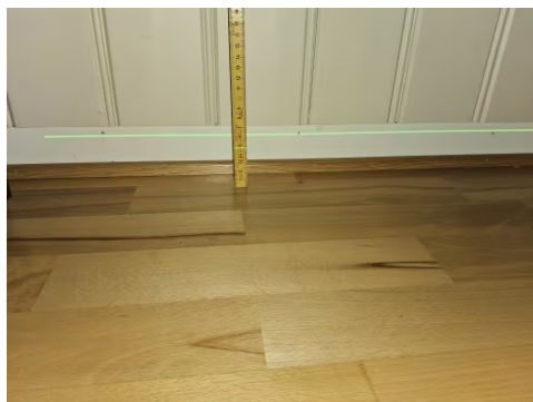
Etasjeskiller er kontrollert med nivelleringslaser.
