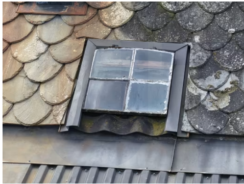
Takvindu bærer preg av høy slitasje.
