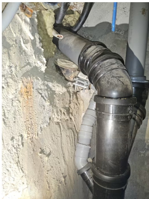
Boligen har avløpsrør plast og støpejern.
