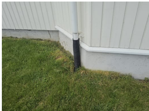
Taknedløp er ført ned i drensrør.
