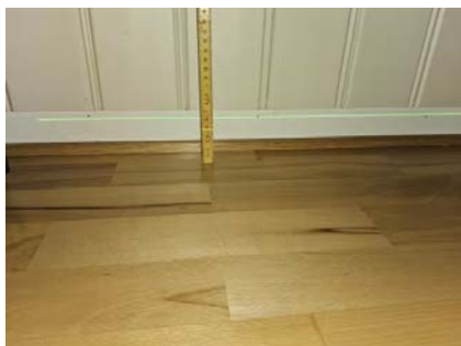
Etasjeskiller er kontrollert med nivelleringslaser.
