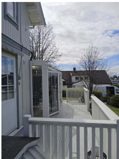
Oversiktsbilde terrasser med vinterhage.
