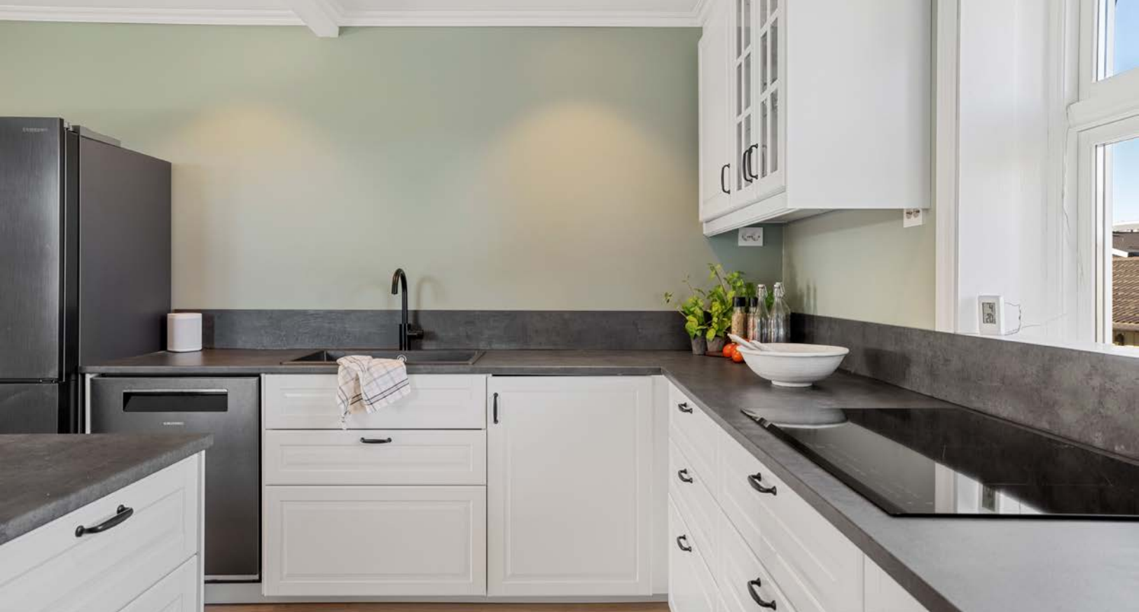
Laminerte benkeplater med plate opp mot veggen som skjerner for sprut og søl. Nedfelt oppvaskkum med ett-greps blande batteri.
