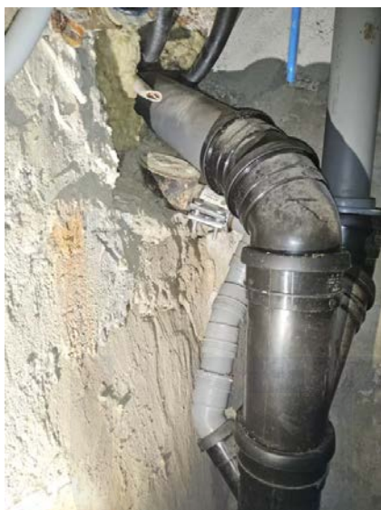
Boligen har avløpsrør plast og støpejern.
