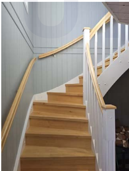
Lukket trapp mellom etasjene.
