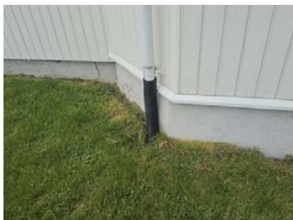
Taknedløp er ført ned i drenerør.
