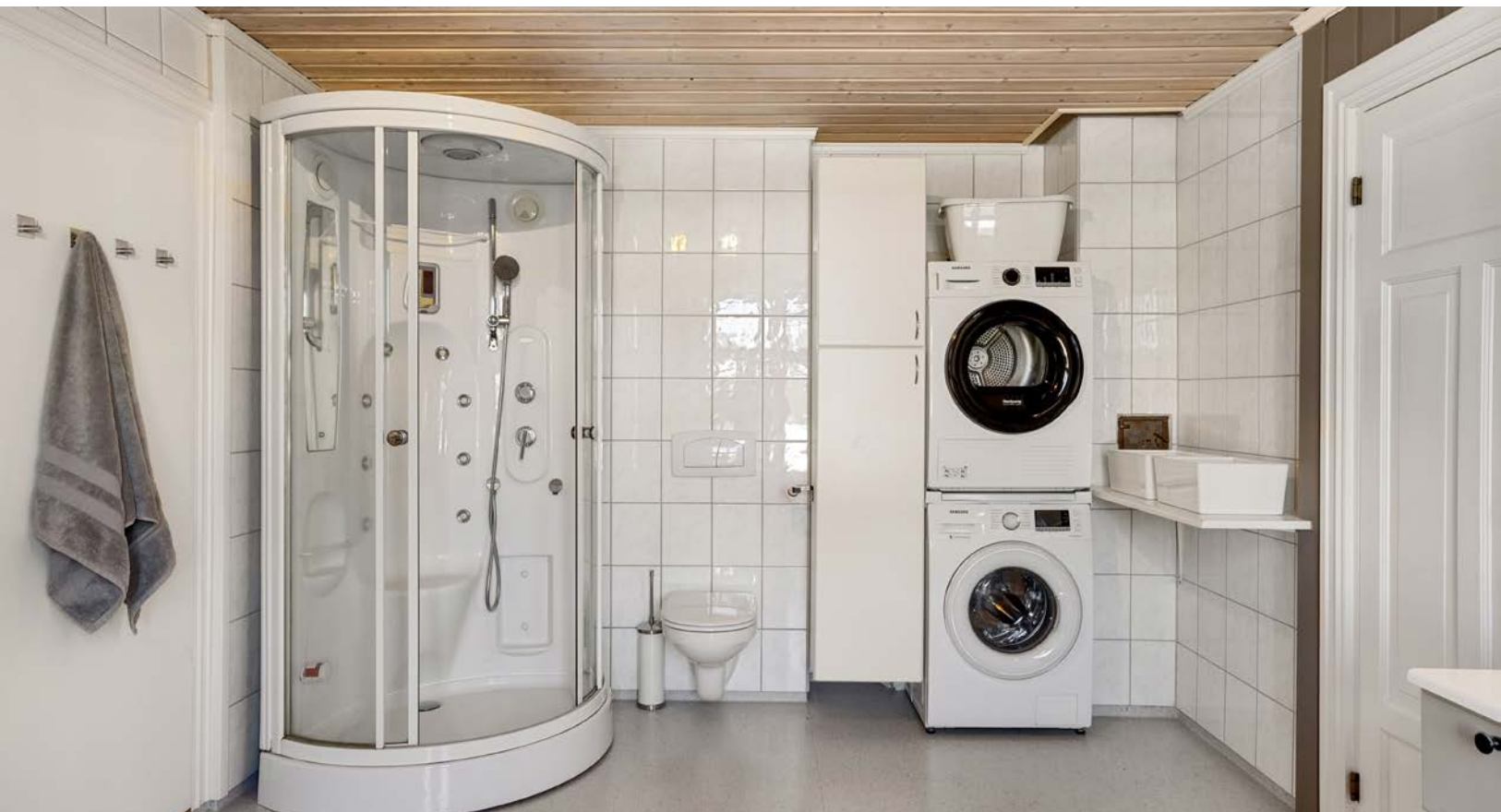
Veggmontert toalett og opplegg for vaskemaskin og tørketrommel.
