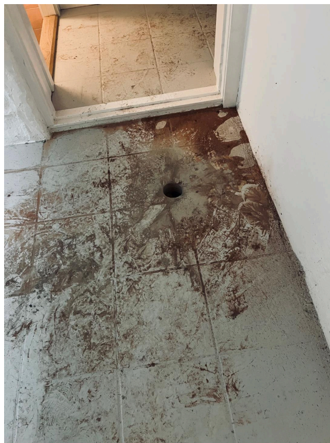
Det er kjerneboret hull i gulv.
