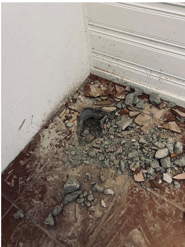
Gulv er pigget opp.
