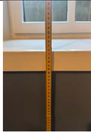
3.2 Høyde opp til vindu = 140,5cm.
