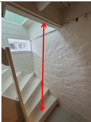
4.2 Bilde av trapp fra nedsiden. Fri høyde måles mellom nederste trinn og trappeveksling.
