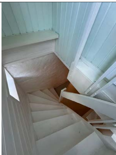
4.1 Bilde av trapp fra oversiden.
