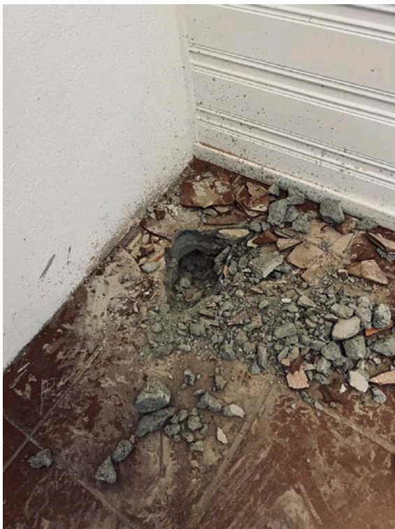
Gulv er pigget opp.
