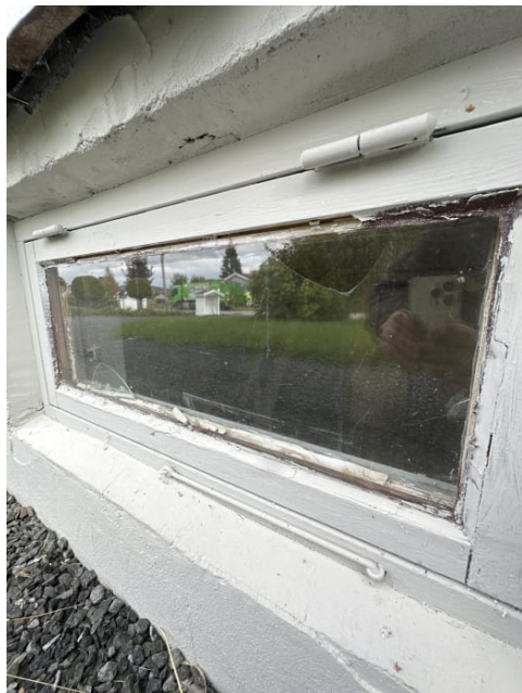
Det registreres knust glass i kjellervindu.
