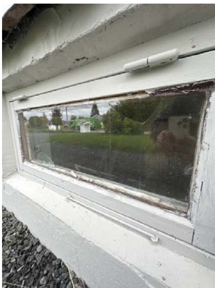
Det registreres knust glass i kjellervindu.
