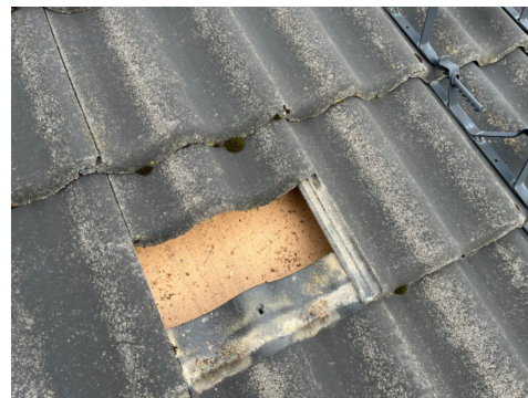
Takstein med undertak av su-tak plater.
