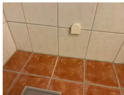
Gjennomføring i dusjsone.
