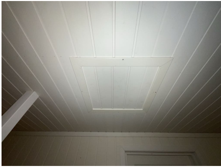
Luke til kryploft er skrudd. Det er lagt isolasjon over luke
