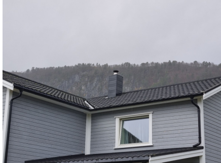
Vindu på soverom 2
