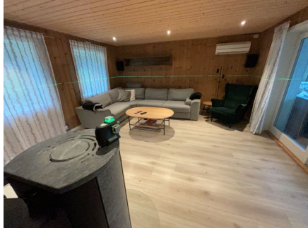
1. etasje Plassering av laser ved kontroll av stue. Det er målt 9 mm høydeforskjell gjennom rommet. TG 1
