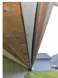
Vegger er foret ut og det er utført tetting med skum mot grunnmur. Ingen avvik er funnet ved stikk kontroll av utforing
