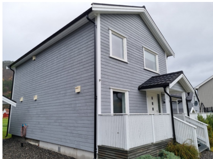
Vindu på vaskerom, gang og stue/soverom 3
