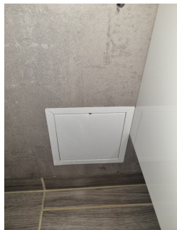
Luke for stoppekrane på toalettrom
