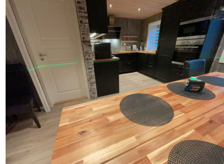
1. etasje Plassering av laser ved kontroll av kjøkken. Det er målt 11 mm høydeforskjell gjennom rommet. TG 1
