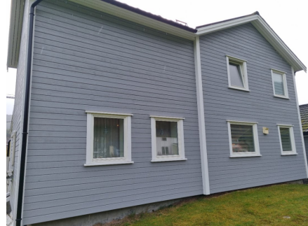
Vindu på stue, kjøkken, soverom 2 og bad
