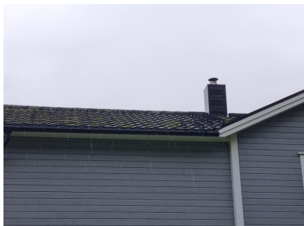
Takstige er montert for tilkomst til pipe
