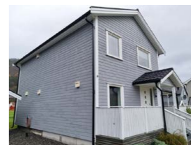
Vindu på vaskerom, gang og stue/soverom 3
