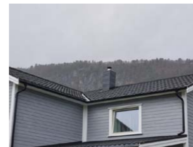
Vindu på soverom 2
