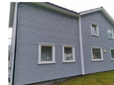
Vindu på stue, kjøkken, soverom 2 og bad
