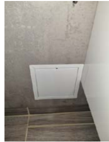
Luke for stoppekrane på toalettrom
