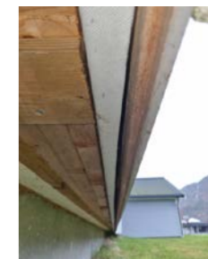
Vegger er foret ut og det er utført tetting med skum mot grunnmur. Ingen avvik er funnet ved stikkontroll av utføring
