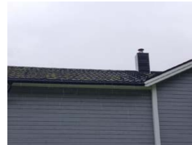
Takstige er montert for tilkomst til pipe
