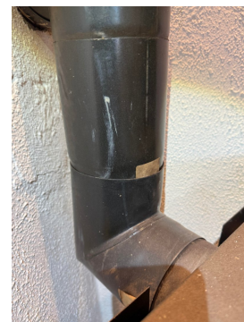
Bilde av glippe mellom ovn og ovnsrør
