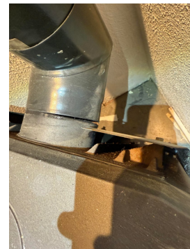
Bilde av glippe mellom ovn og ovnsrør
