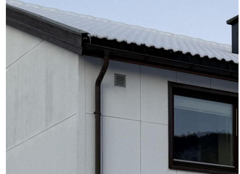
Bilde av ventil fra avtrekksvifte på yttervegg
