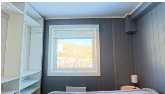
Bilde av yttervegg på soverom
