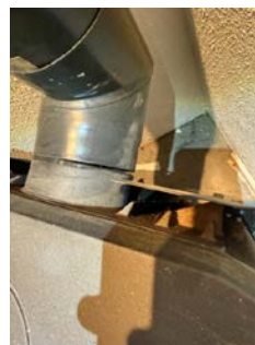
Bilde av glippe mellom ovn og ovnsrør
