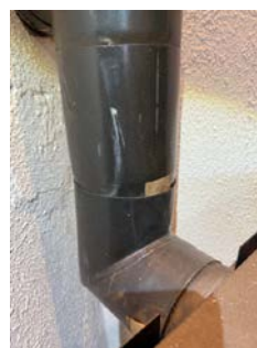
Bilde av glippe mellom ovn og ovnsrør
