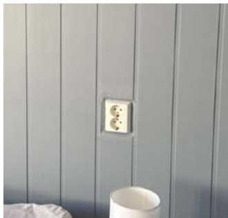
Bilde av veggplate med utskjæring for kontakt
