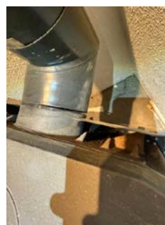
Bilde av glippe mellom ovn og ovnsrør
