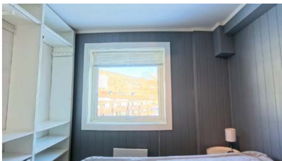
Bilde av yttervegg på soverom
