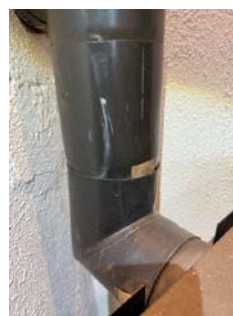
Bilde av glippe mellom ovn og ovnsrør
