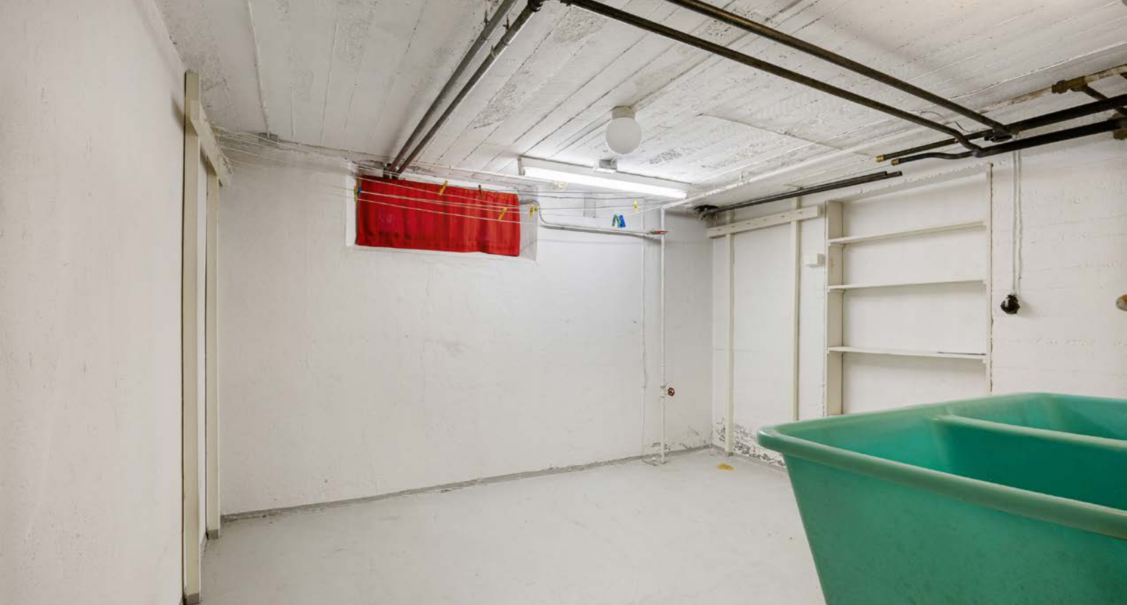
Vaskerommet i kjelleren har enkel standard og sluk i gulvet.
