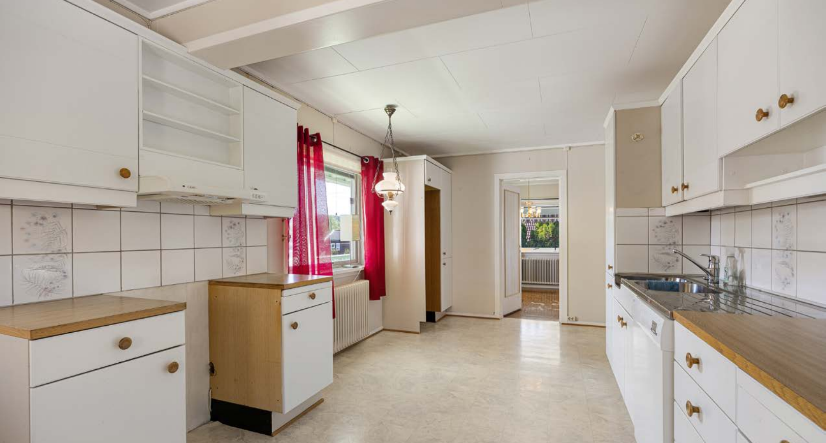
Hvite fliser er montert over benken, og over kokesonen er det ventilator med avtrekk ut. Opplegg for oppvaskmaskin er etablert.
