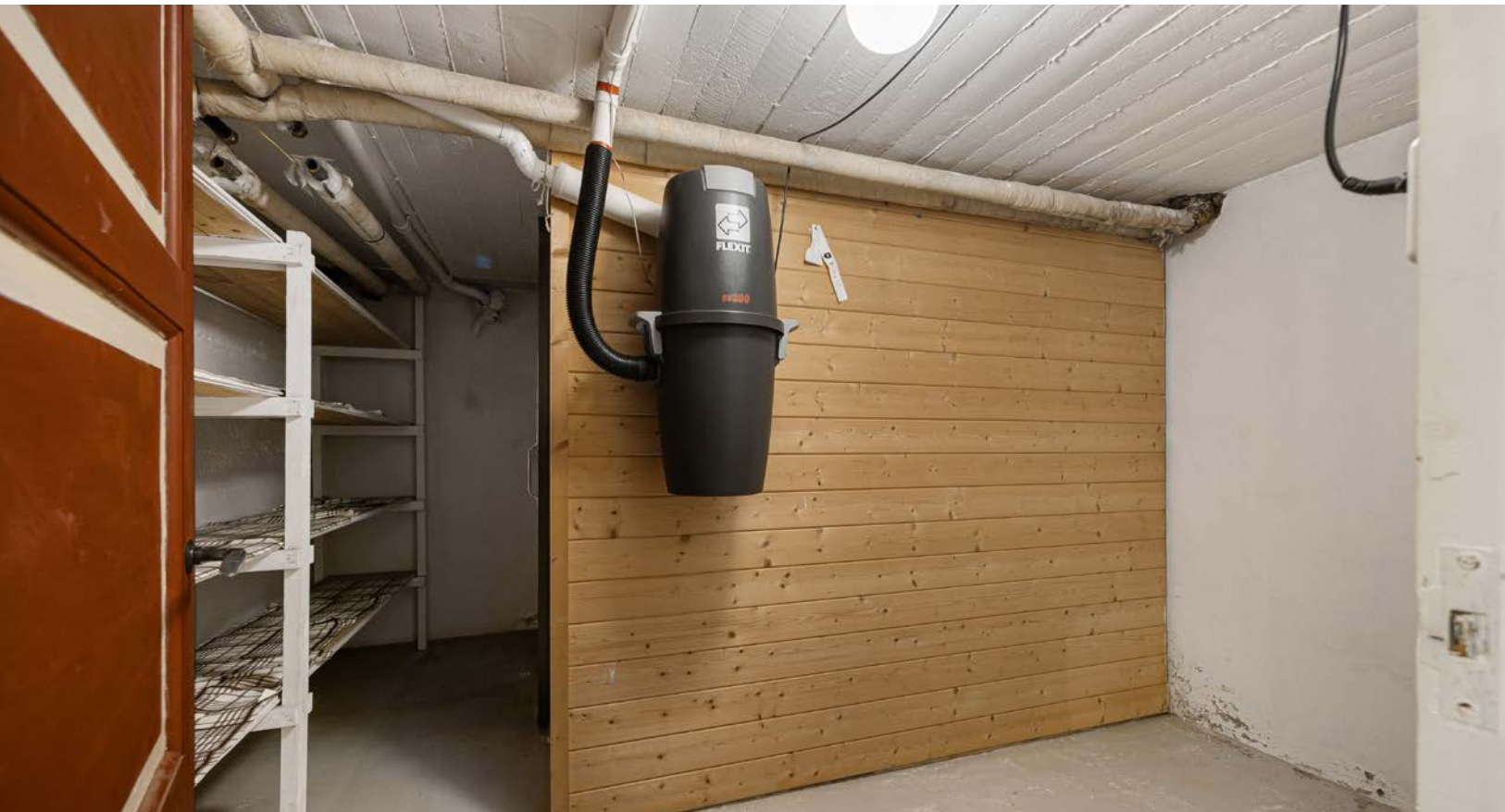
Etasjen har flere boder for praktisk oppbevaring, og bak treveggen er det et kjølerom.
