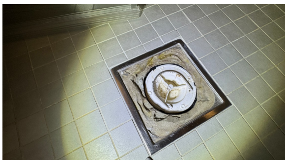
Kontroll av sluk.
