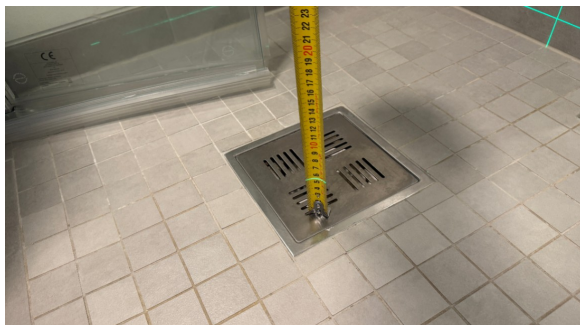
Kontroll av fallforhold.
