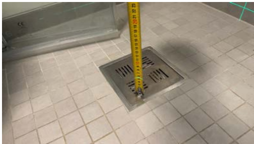
Kontroll av fallforhold.
