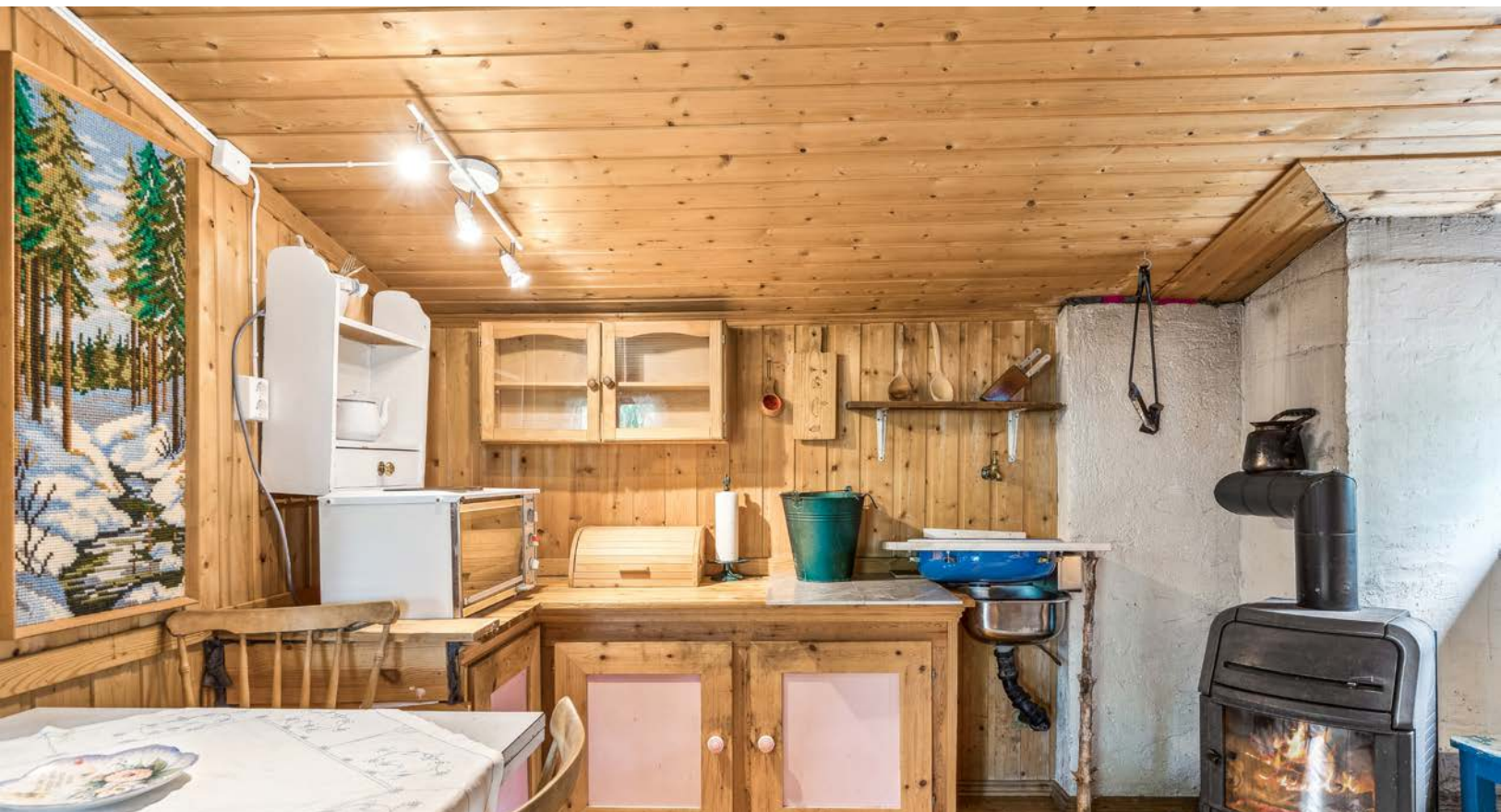
Plassbygget kjøkkeninnredning fra byggeår med furuskrog og furu fyllingsdører og fronter.
