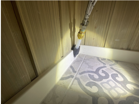
Rørgjennomføring dusjsone (ugunstig)
