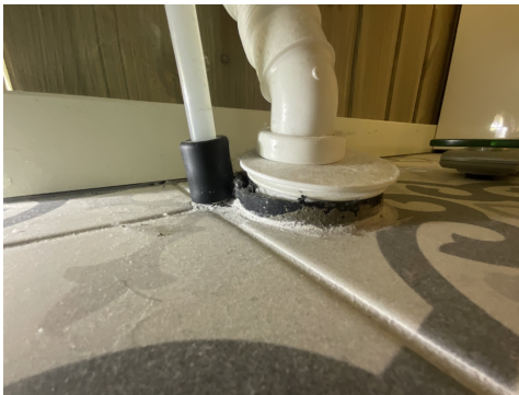
Rørgjennomføring dusjsone (ugunstig)
