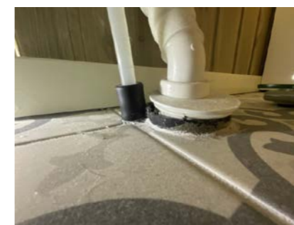
Rørgjennomføring dusjsoner (ugunstig)
