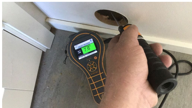
LOFT/ 2 ETG > BAD
