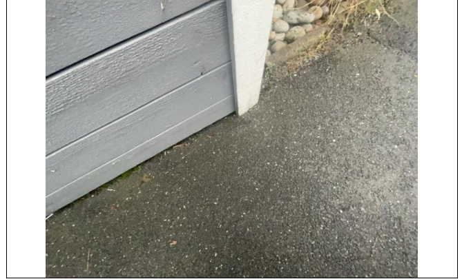
Trekonstruksjoner ned mot terreng på utvendig bod
