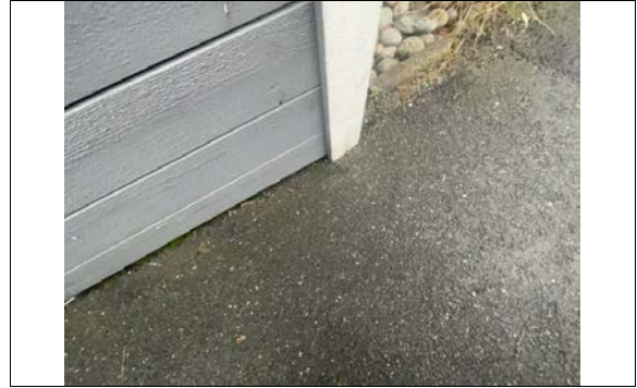
Trekonstruksjoner ned mot terreng på utvendig bod
