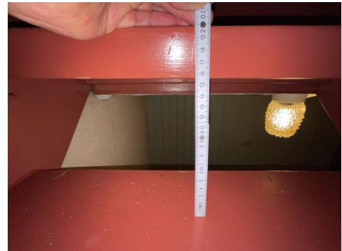
Åpning mellom trinn er 15,5 cm.
