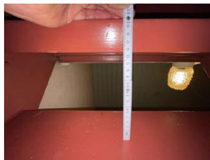
Åpning mellom trinn er 15,5 cm.
