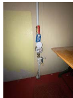
Vannmåler og stoppekran i kjeller.
