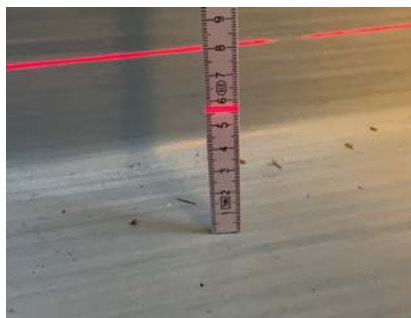
Høyde gulv ved dør.
