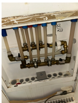
Samleskap plassert bak kjøleskap
