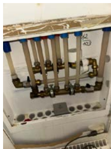
Samleskap plassert bak kjøleskap
